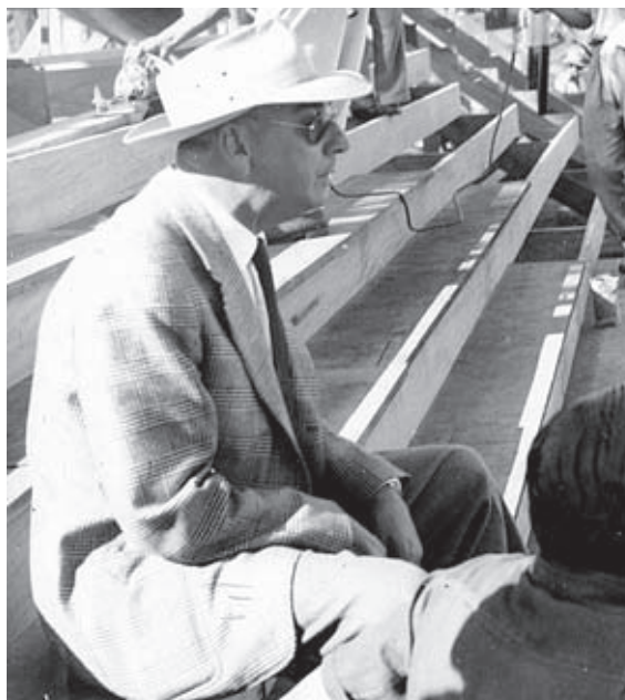
Lutz acompanhando as obras de ampliação do estádio Alfredo de Castilho em 1954
