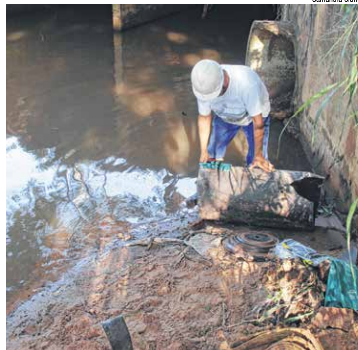
Técnicos trabalharam por dois dias para reparar a adutora
