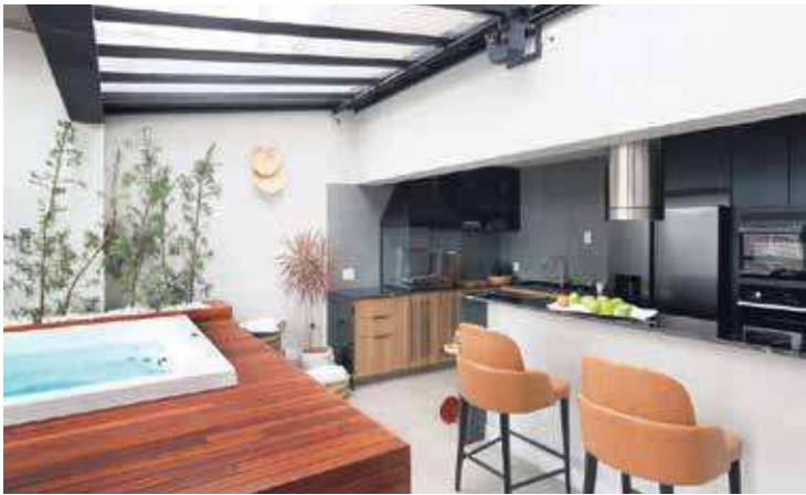
Em coberturas, Bruno também enfatiza que o fechamento do forro para obter as mesmas vantagens do envidraçamento horizontal da varanda: isolamento térmico e acústico, proteção a intempéries e privacidade. Neste projeto, o arquiteto projetou uma abertura e fechamento automática com motor e estrutura de policarbonato - Projeto BMA Studio
